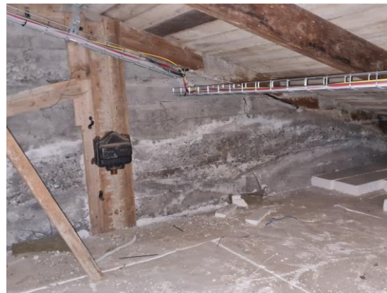
Mynd 17 Lekaummerki voru sjáanleg á eldra þaki. Líklega frá því áður en þakjárn var endurnýjað.
