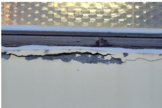
Mynd 14 Gluggar eru orðnir veðraðir og töluverðar múrskemmdir eru sjáanlegar í kringum þá.
