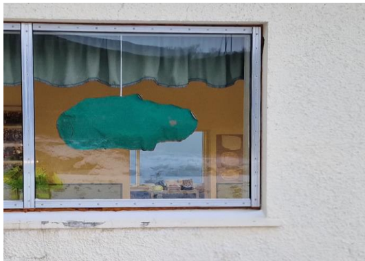
Mynd 12 Glugga þéttingar eru ófrágengnar á bakhlið.
