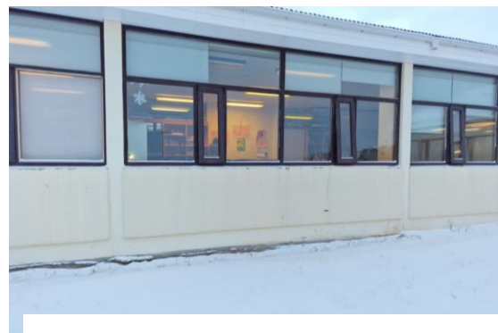
Mynd 15 Gluggar í kennslustofum líta sæmilega út en þarfnast yfirferðar og viðgerða. Best væri að endurnýja alla glugga hússins.
