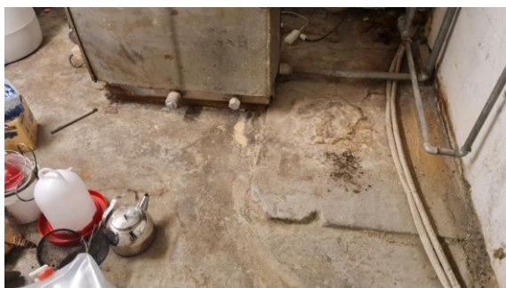
Mynd 20 Fjarlægja ætti allar aflagðar lagnir frá kyndiklefa.
